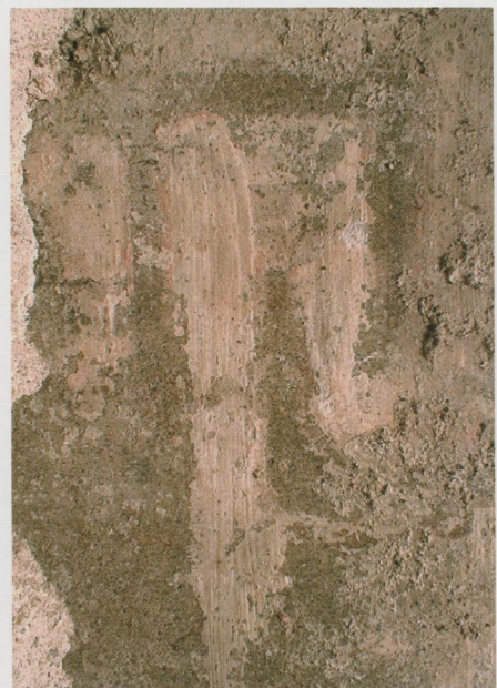
C. Particolare di finitura a calce.
